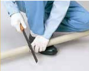
切断箇所は全周にわたってマーキング等を行い、のこぎりを用いて管軸に直角に切断してください。
