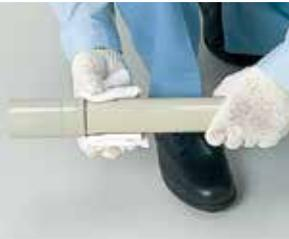
管が継手より抜け出なくなるまで管と継手を保持します。(30秒以上保持)
